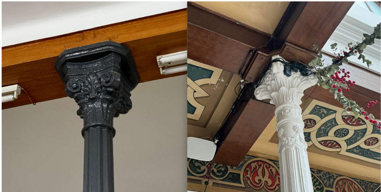
Sistema porticado de pilares de hierro fundido y vigas de madera.
