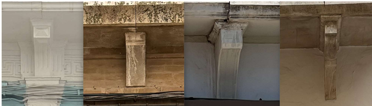
Canecillos de piedra Casa Ariza, La Aurora, Casa ALM (Casino Liceo) y Borrego 3.
