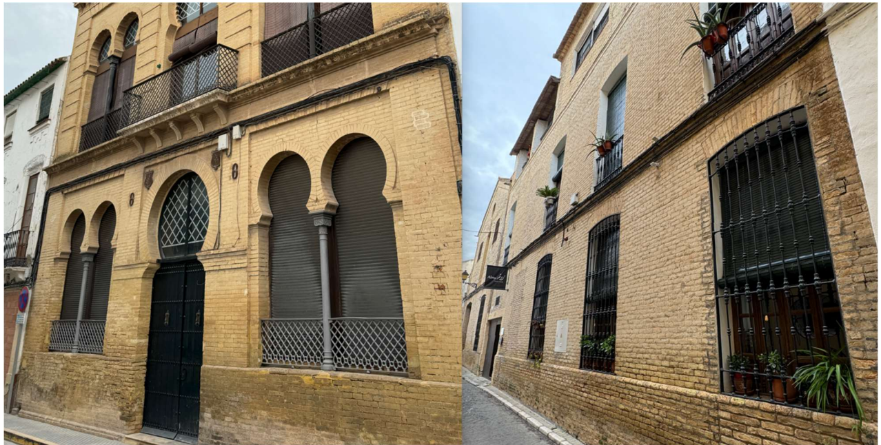
Fachadas de ladrillo visto en La Aurora y Borrego 3. Detalle del zócalo.
