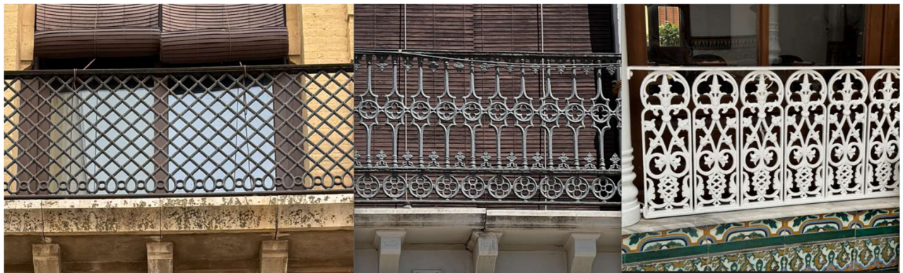
Barandillas La Aurora, Casa ALM (Casino Liceo) y Borrego 3.
