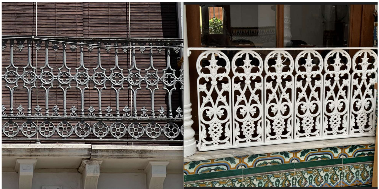
Detalle barandillas Casa ALM (Casino Liceo) y Borrego 3.
