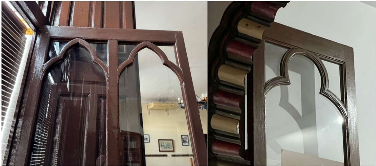
Travesaños con arco trilobulado en la Casa ALM (Casino Liceo) y Borrego 3.
